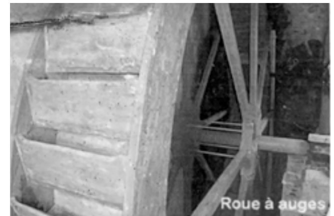
La roue du moulin Coquart de 5 m de diamètre.
