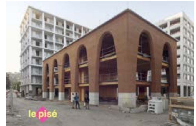
L'Orangerie , 1er bâtiment de bureau en terre crue, Lyon. C. Vergely architectes et l'entreprise Le Pisé de N. Meunier.
