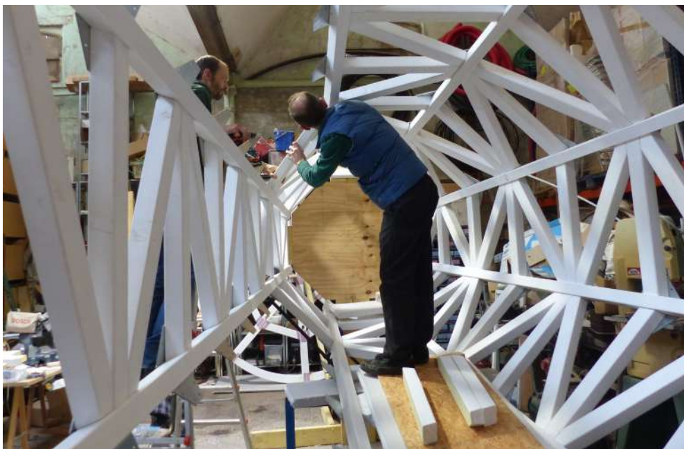
Le bulbe et la tour sont construits séparément - La tour est assemblée allongée.
