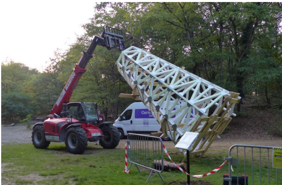
Transport et installation sur le site choisi.
