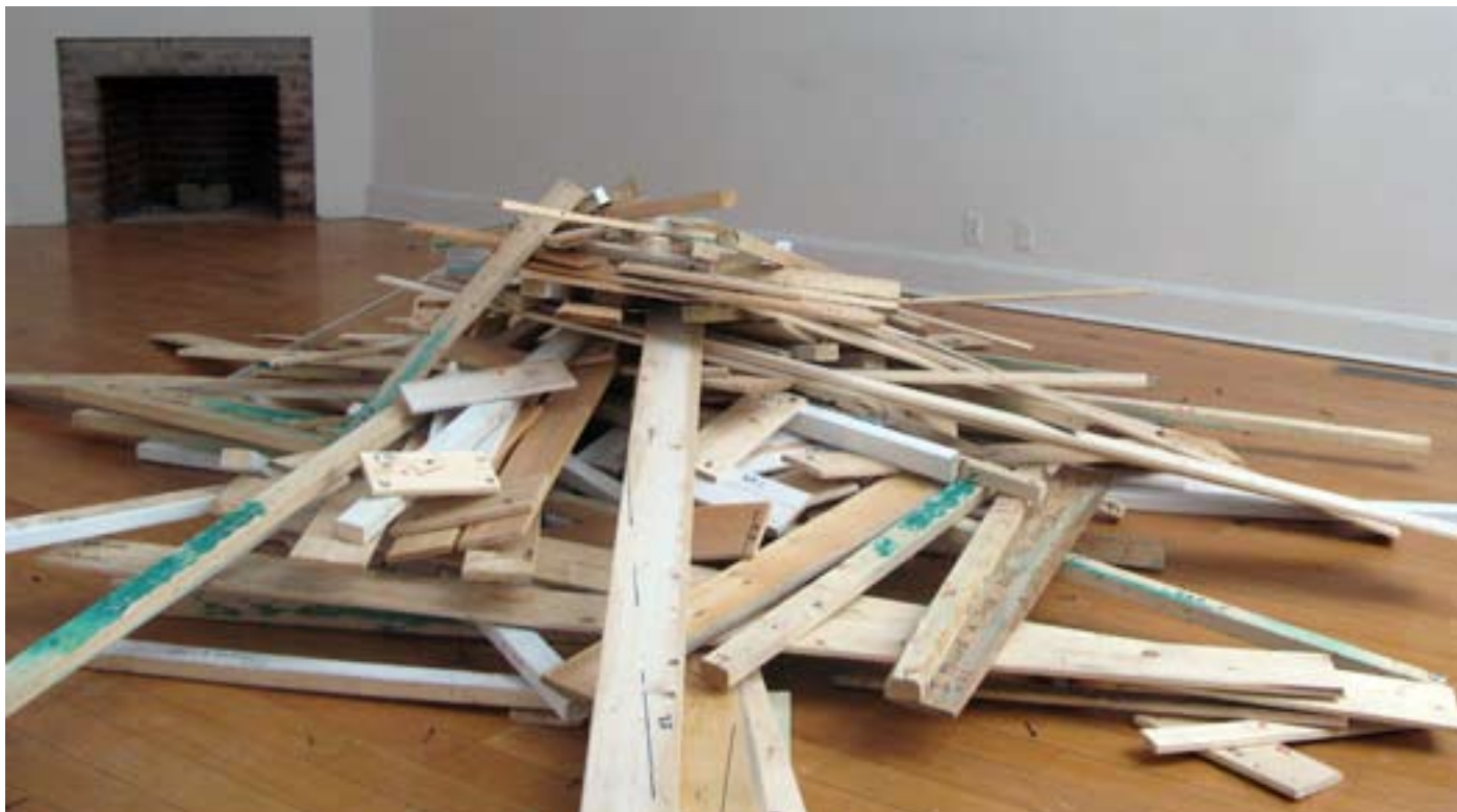
Le stock après le démontage de l'escalier dans l'escabeau
