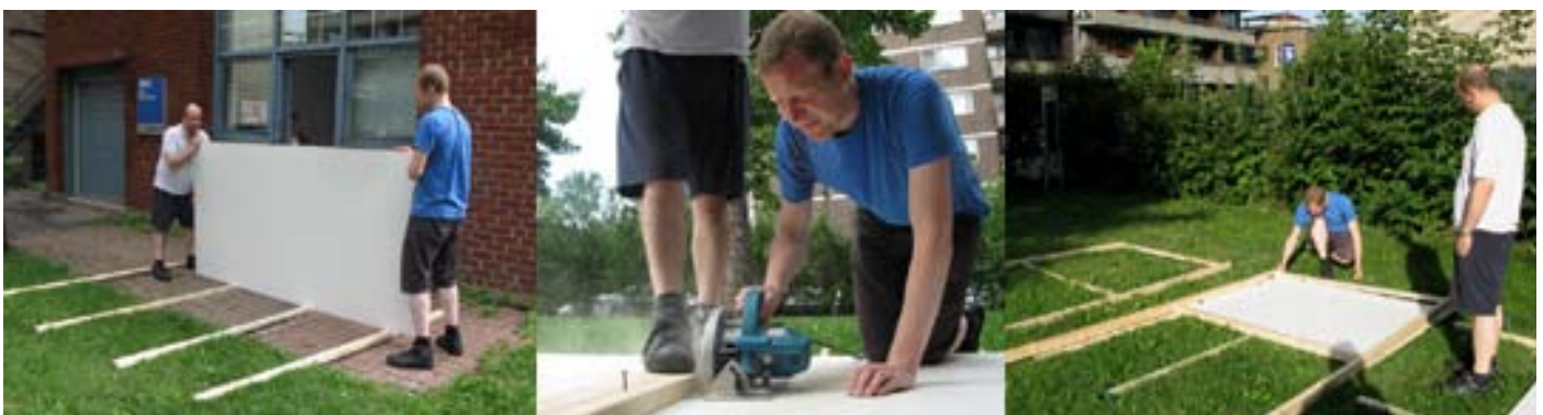
La construction des écrans
